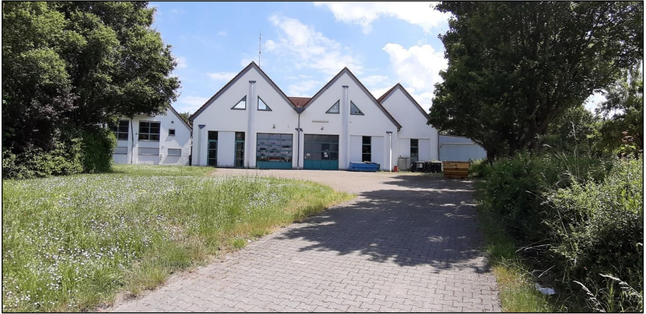
Abbildung 7: Bestandsgebäude der Freiwilligen Feuerwehr entlang der Straße „Am Westring“; rechter Bereich wird in der Planung abgerissen (Rückseite)
