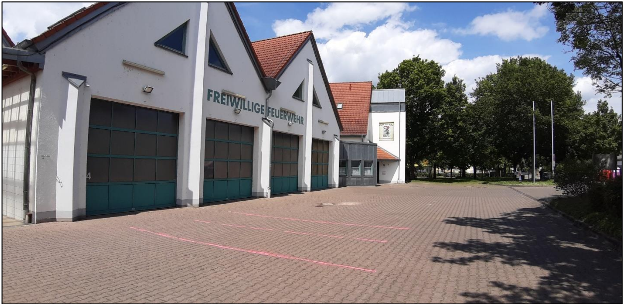
Abbildung 5: Bestandsgebäude der Freiwilligen Feuerwehr entlang der Ritter-Hundt-Straße (Vorderseite)
