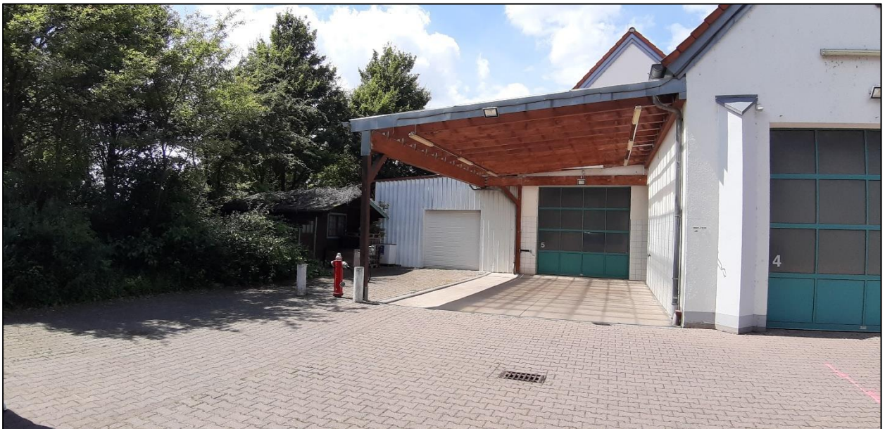
Abbildung 6: Bestandsgebäude der Freiwilligen Feuerwehr entlang der Ritter-Hundt-Straße, die in der Planung abgerissen werden; links: Anbau (Vorderseite)
